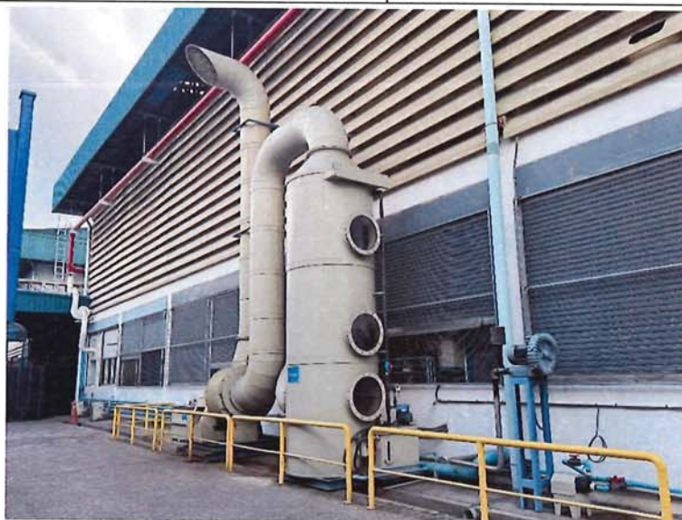
ภาพที่ 51 การติดตั้งระบบ web scrubber
